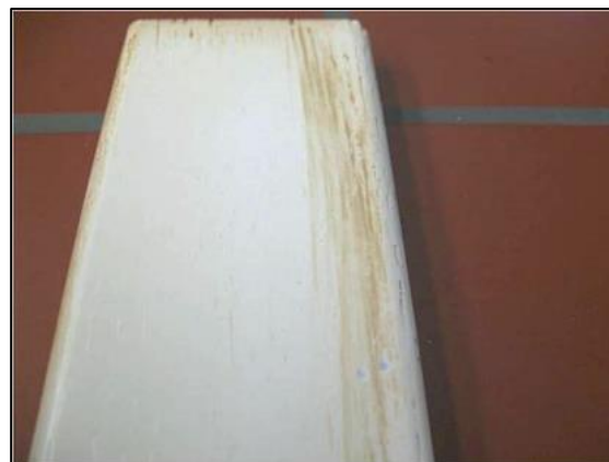
Obr. 2.5: Zafarbenie povrchovej úpravy v dôsledku rozpustných extraktívnych látok obsiahnutých v dreve
